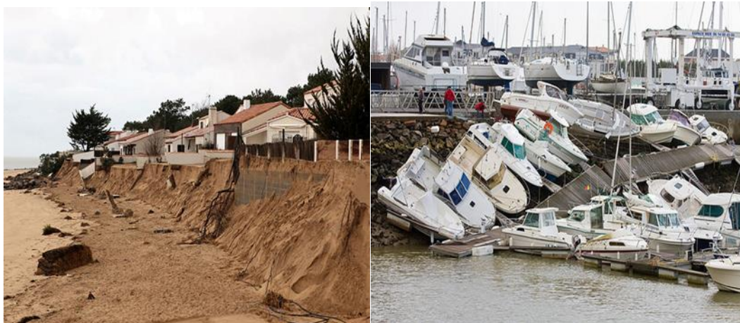
Fig. 2. Tormenta Xynthia (febrero 2010) en la costa atlántica del sur de Francia y el polígono de la zona afectada por el temporal. Algunas fotografías de los efectos causados en el litoral.
